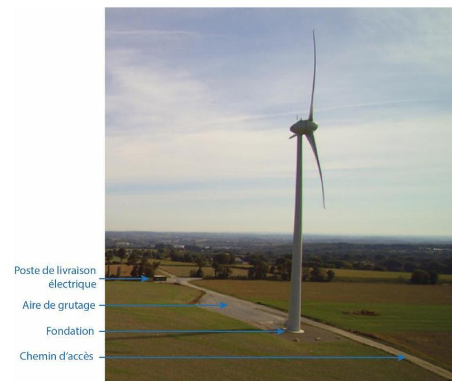
Figure 3 : Une éolienne et ses aménagements annexes (Source : AEPE Gingko)
