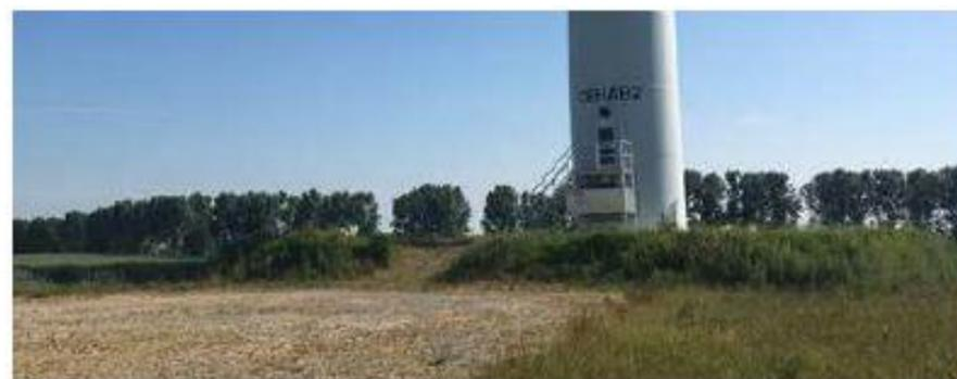
Photo 5 : Exemple de butte en cas de surélévation des fondations
