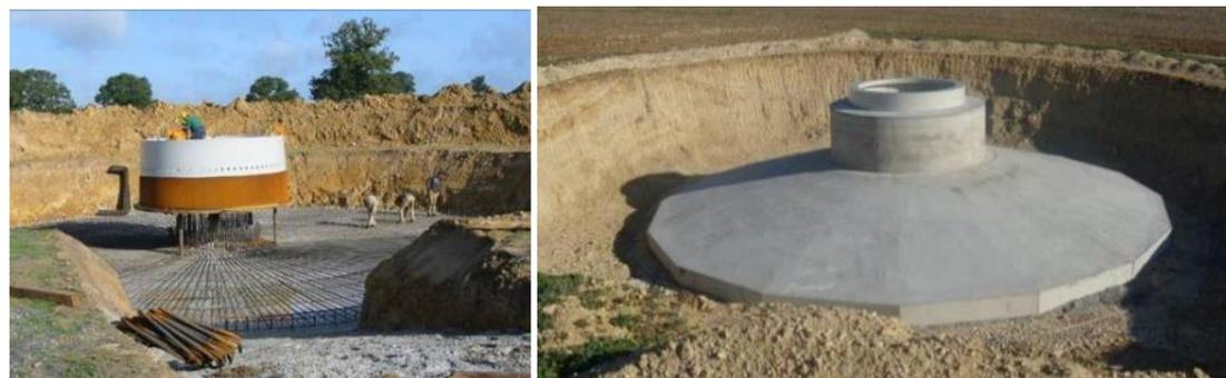
Photo 4 : Le ferrailage et le coulage d'une fondation d'éolienne
