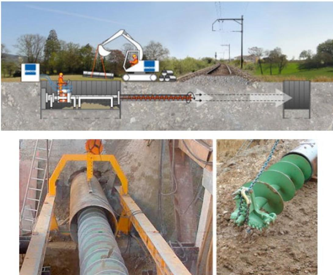
Figure 46 : principe du forage horizontal (source : ZMOOS)
