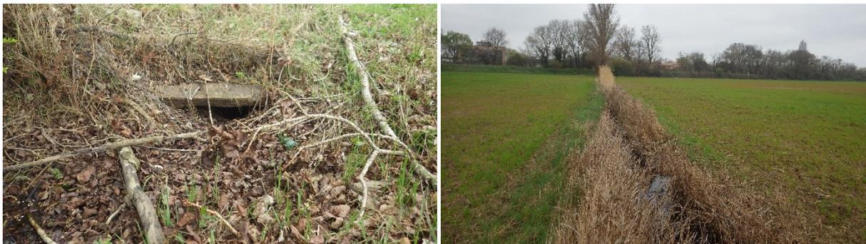
Figure 8: Ouvrage hydraulique comblé sur le fossé à l'aval du périmètre de la ZAC et ce même fossé avec eaux stagnantes
