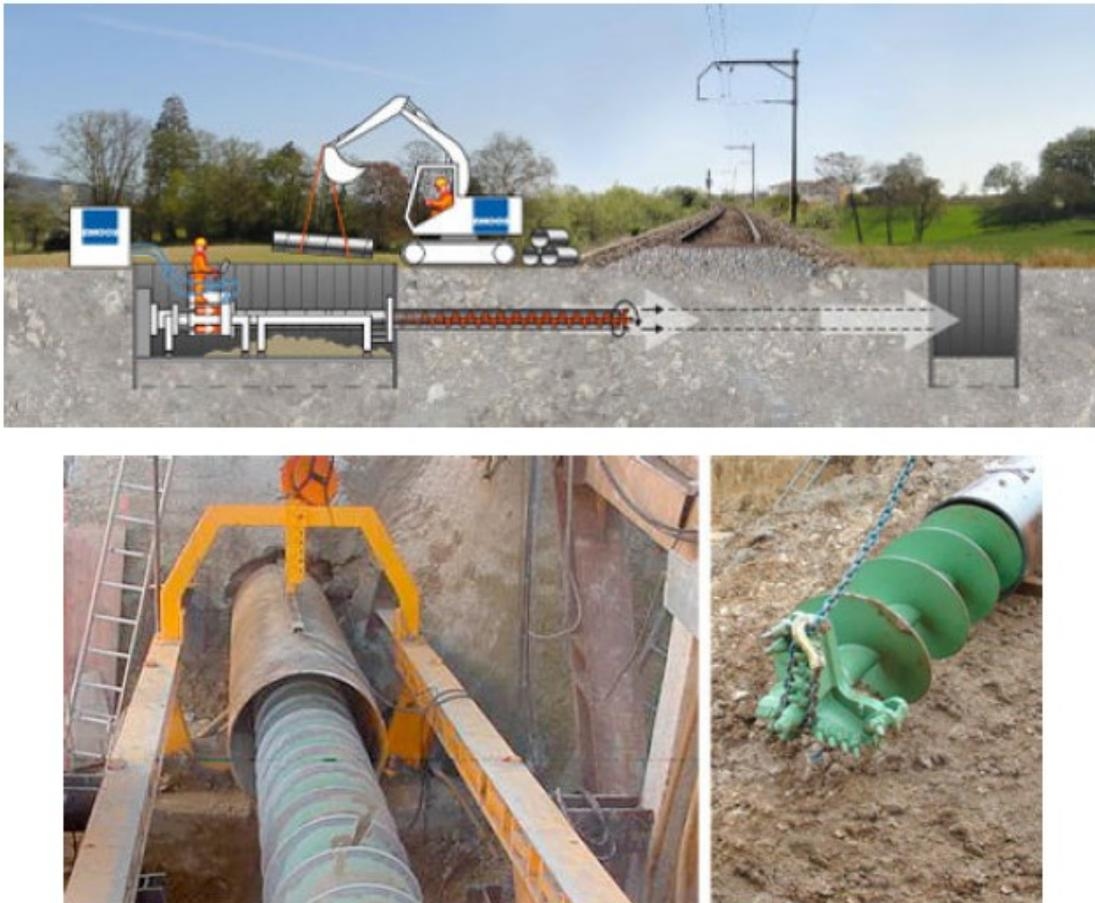
Figure 4 : Principe du forage horizontal (source : ZMOOS)
