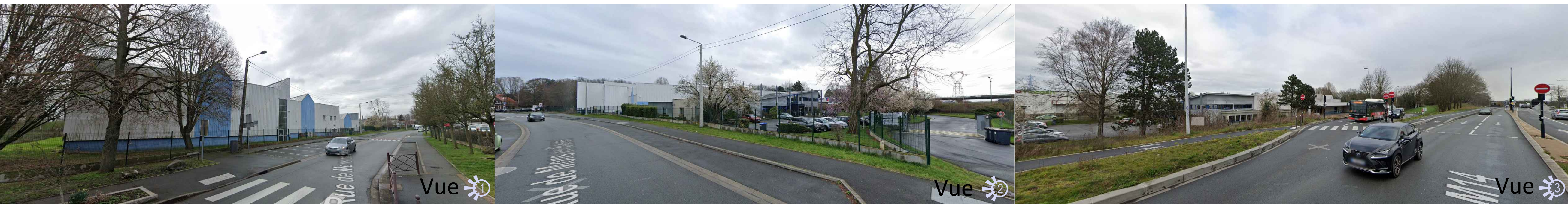
A2=PD3 PHOTOS DES BATIMENTS A DEMOLIR
