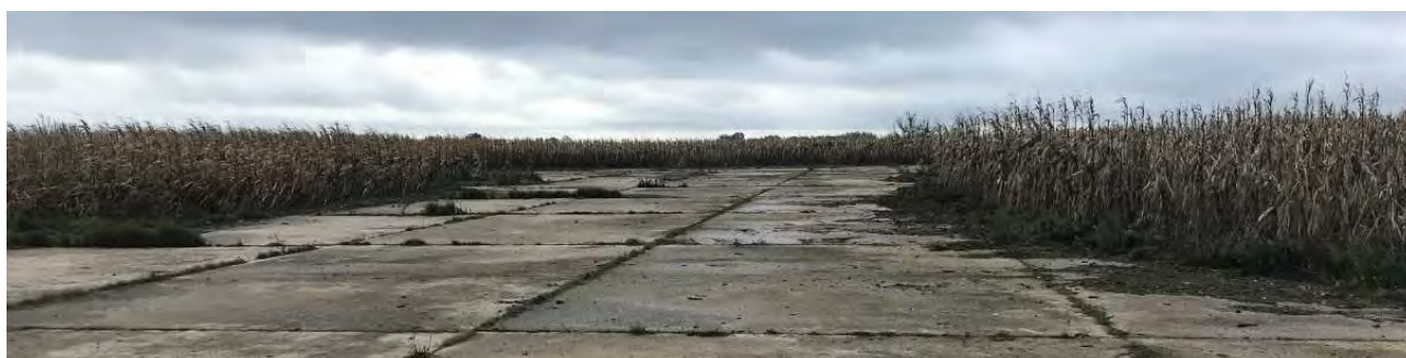
Figure 51 : Vue depuis le sud de la Marguerite est
