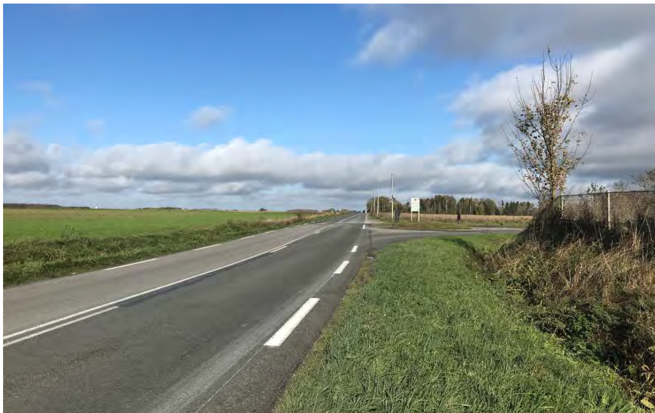
Photographie 27 : Vue sur la D15 (nord) et la Route de l'étang de Morillas
