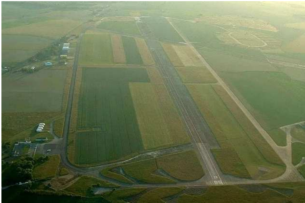
Figure 73 : Vue de l'Aérodrome de Coulommiers-Voisins depuis l'est
