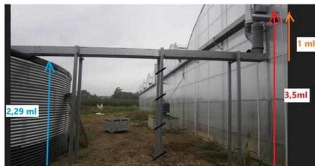
Figure 10 : Photographie d'illustration du collecteur aérien des eaux de pluie alimentant les réservoirs de récupération (source : Pièce 2 - Notice descriptive du projet, p.21)
