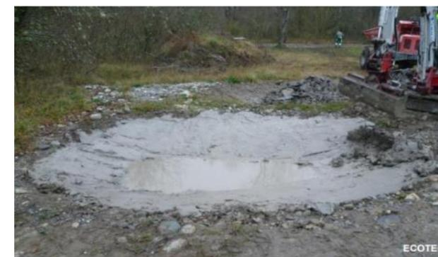
Mare sur sol perméable avec pose d'argile lissée au godet, Raclerets, 2011
