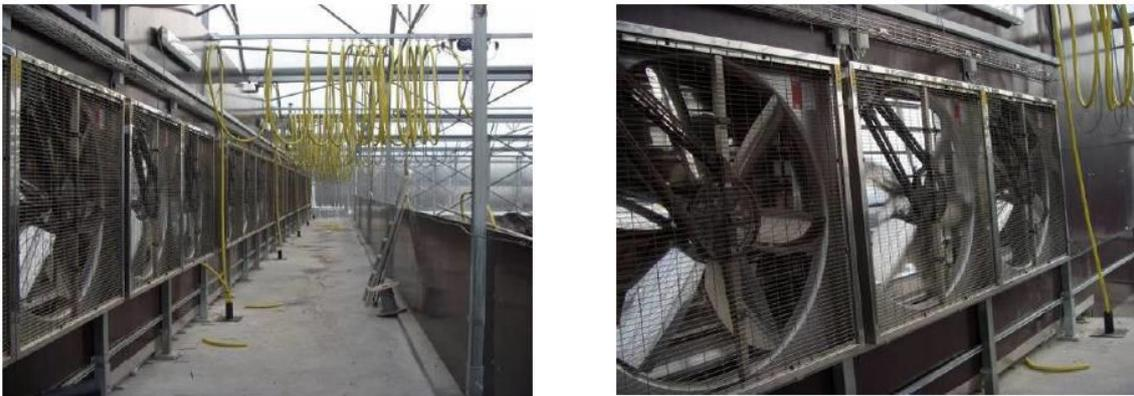
Figure 10 : Vue intérieure de la galerie supérieure et ventilateurs d'extraction
