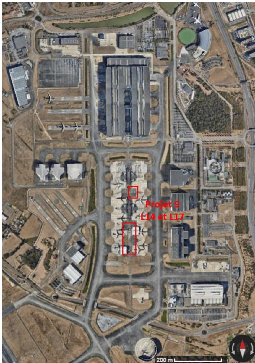
Figure 13 : Zone du projet 9 en situation actuelle
