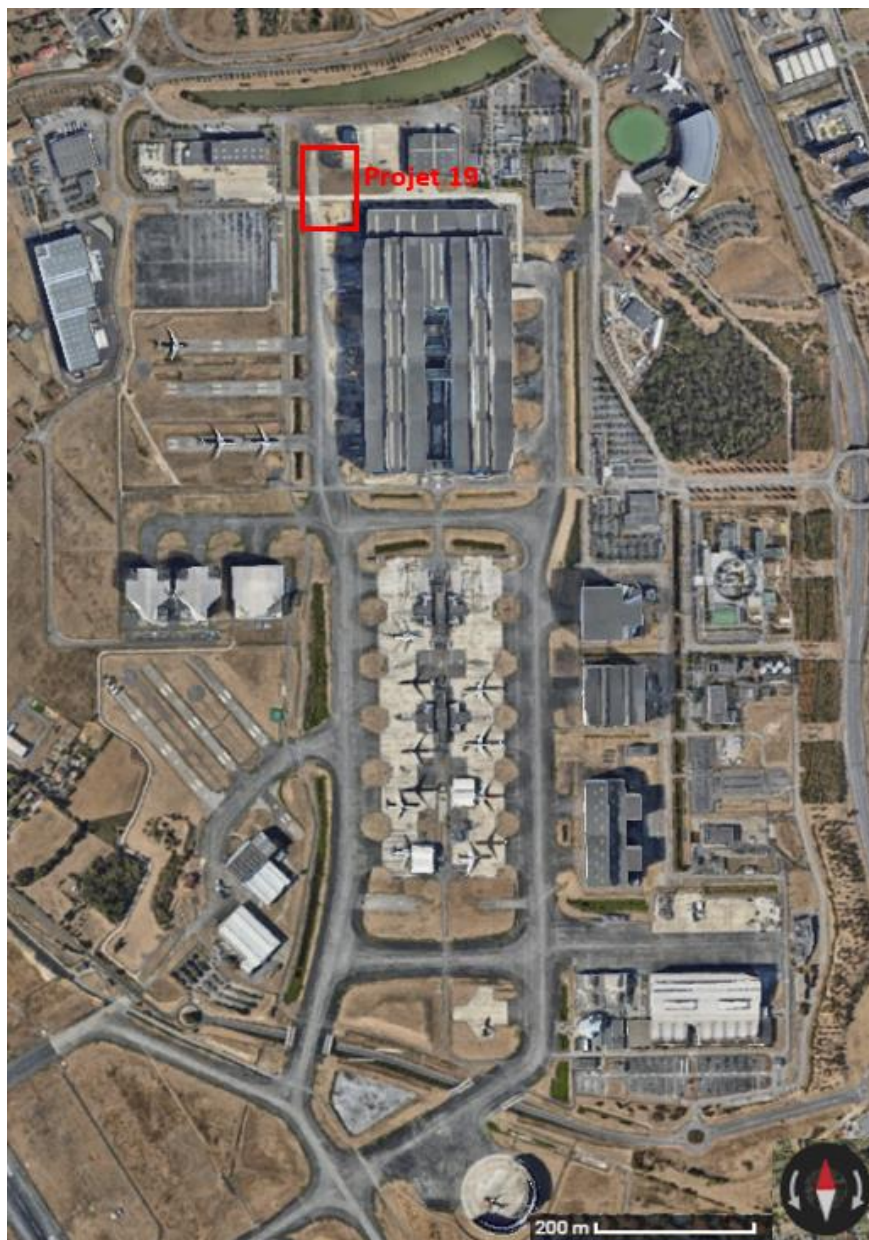
Figure 28 : Zone du projet de hangar L86 en situation actuelle
