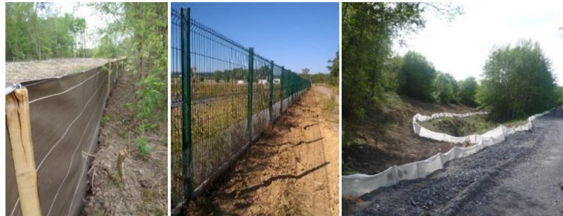
**Exemples de clôtures provisoire anti-amphibiens (de gauche à droite : toile polypropylène, grillage en acier galvanisé, géotextile)**
