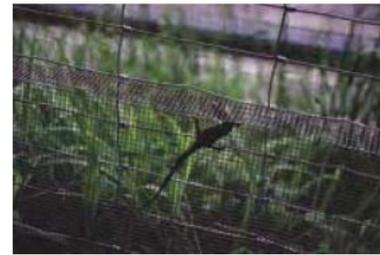
**Triton escaladant un treillis de 6,5x6,5 mm plaqué sur un treillis noué à spirale, l'ascension est stoppée par le rabat (partie supérieure recourbée (source : SETRA, 2008)).**
