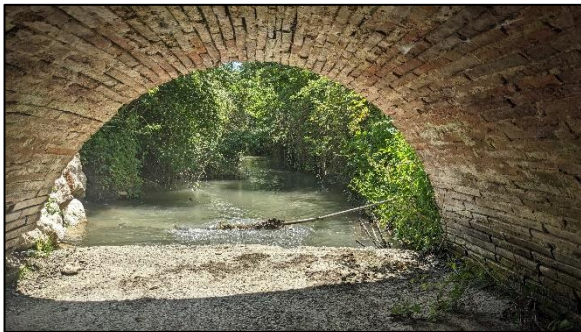
Mai 2024 – Pont maçonné
