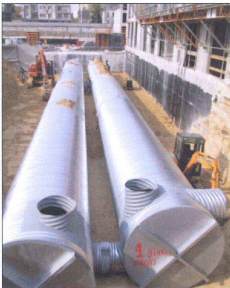
Figure 5 : exemple d'installation de stockage d'eaux pluviales de type Turbosider (source Turbosider.fr)
