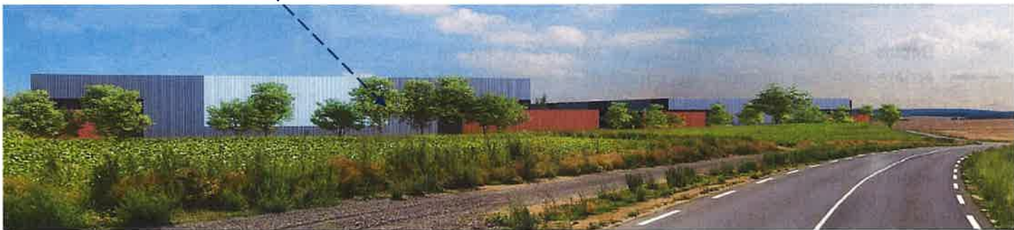
Vue de la route de Fresnoy depuis l'Es
