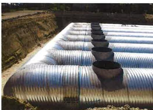
Photo du dispositif retenue avec seulement deux rangs
