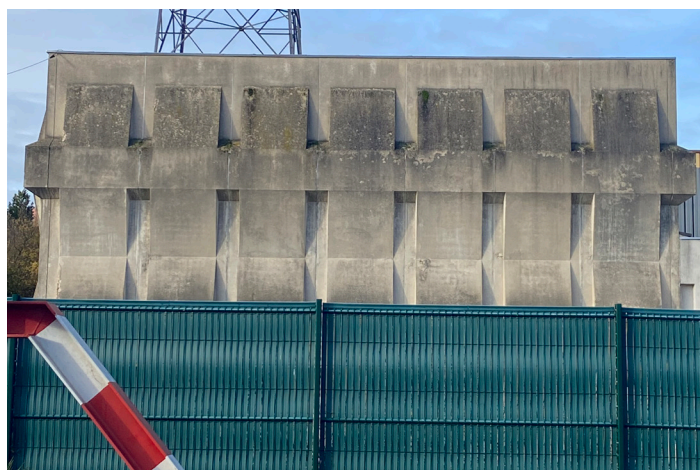
Photographie depuis l'extérieur
