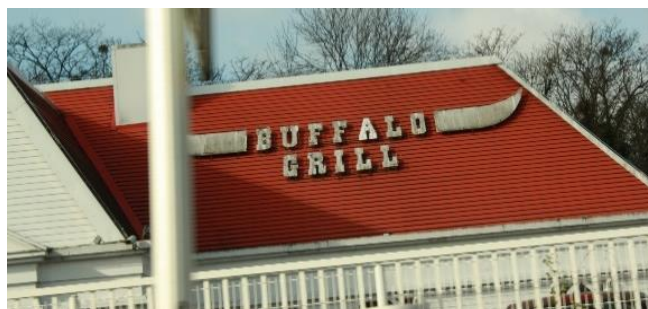
Toiture en pente
