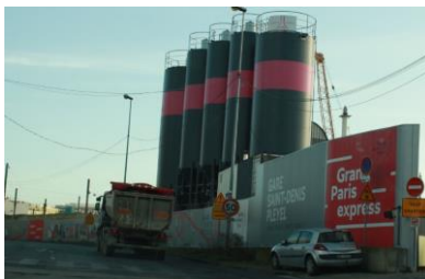
Chantier du Grand Paris Express – Saint-Denis
