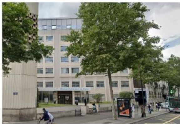
Hôpital Européen de Paris, rue H. Barbusse, Aubervilliers
