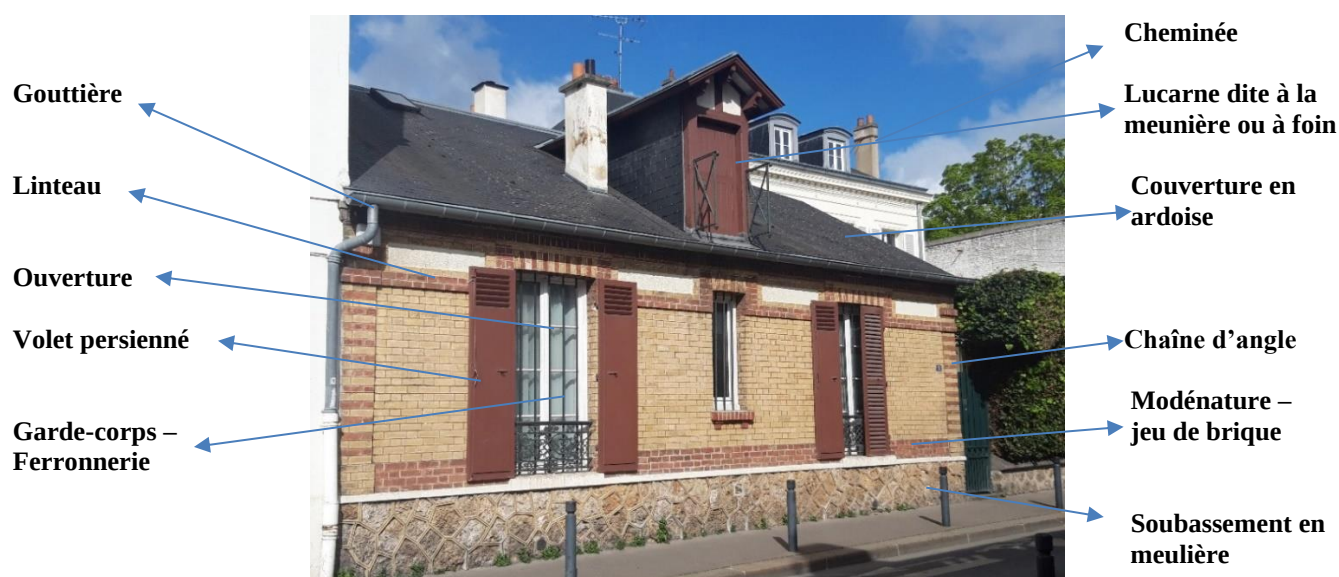
Façade en briques et soubassement en meulière – Saint Denis
