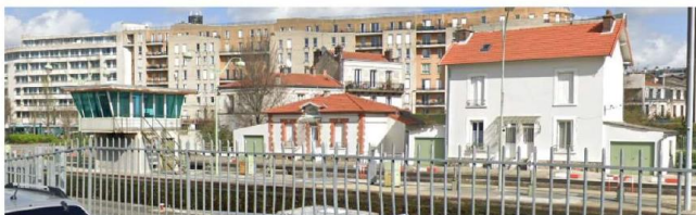
Ensemble éclusier, quai du Port, Saint-Denis
