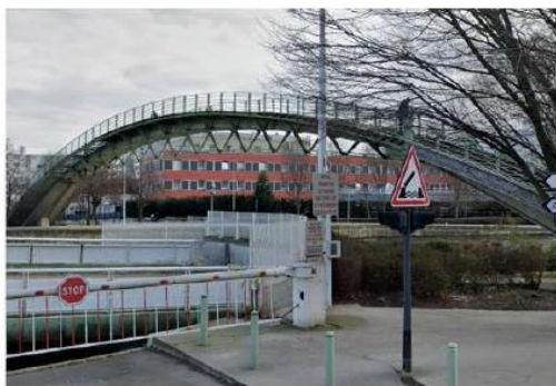
Passerelle du Franc Moisin, Saint-Denis
