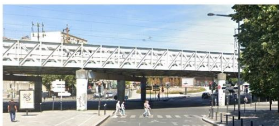
Pont ferroviaire, av. du président Wilson, Saint-Denis
