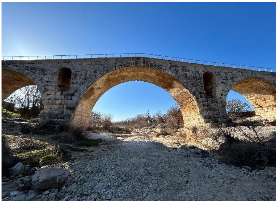
Le Pont Julien au nord de Bonnieux
