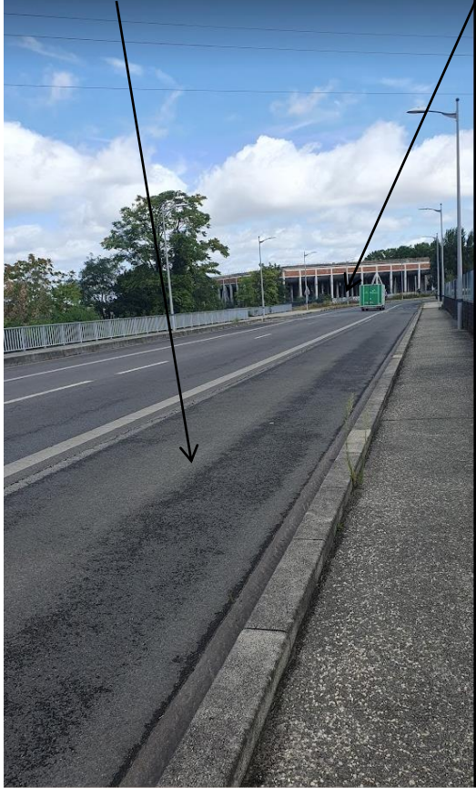
Pont existant qui sera aménagé
