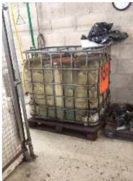
(6) Stockage de déchets liquides récupérés (l'atelier est équipé d'une rétention intégrée au sol. Cette dernière n'est pas équipée de système de détection de fuite / absence de vérification de l'étanchéité de la rétention)
