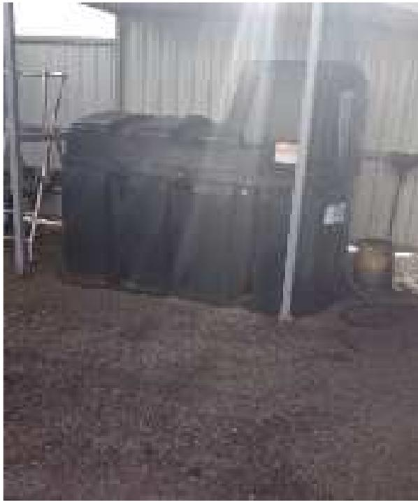
(9) Cuve de fuel aérienne sous auvent en double paroi
