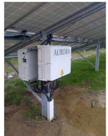
Figure 147 : Boîtier de connexion fixé à l'arrière de panneau
