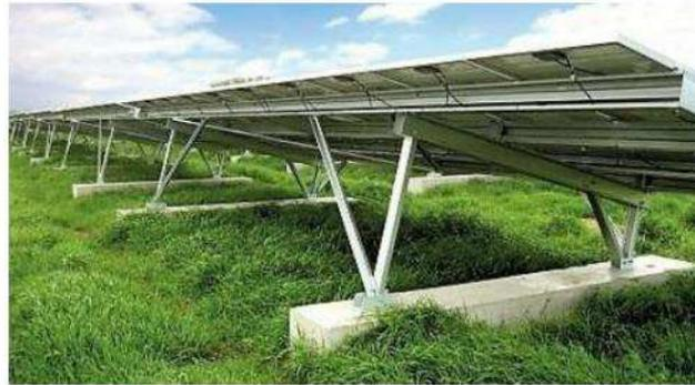
Figure 146 : Illustration de panneaux avec des longrines béton comme fondations
