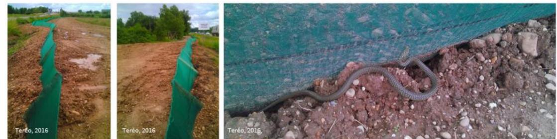
Photo 22 : Barrière anti-intrusion installée sur un chantier
