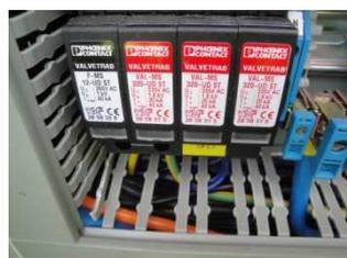
**Photo n2** : Parafoudre sur TD REFROIDISSEUR GAZ.
