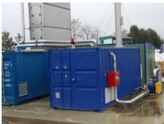
**Figure 4 : Installation de valorisation thermique du biogaz : conteneur chaudière (à droite) et conteneur « évaporateur de lixiviats » (à gauche)**
