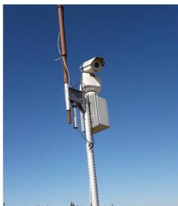
**Figure 19 : Caméra thermique située à proximité d'un casier en exploitation**
