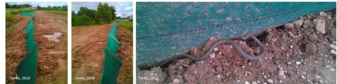
Photo 28: Barrière anti-intrusion installée sur un chantier
