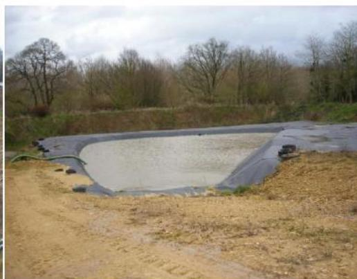
Photo 44 – lagunes EP nord de rétention et d'infiltration (BV3)
