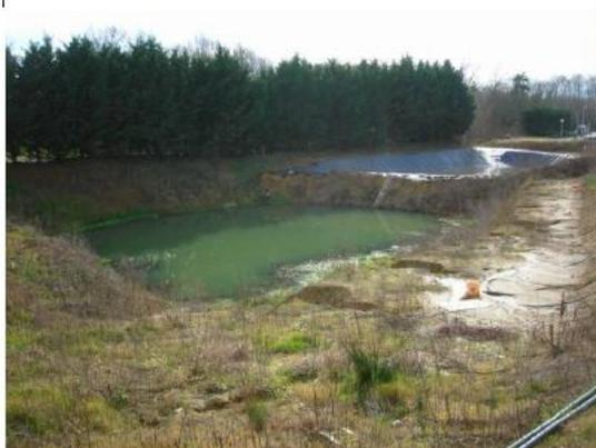
Photo 43 – lagunes EP sud de rétention et d'infiltration (BV1)
