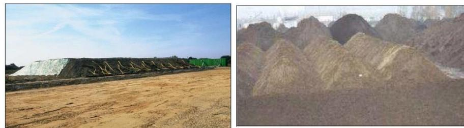
Figure 11 : Exemple de piles et andains de terres souillées
