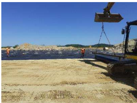
Figure 170 : Déroulement de la géomembrane (à gauche) et recouvrement de terre après pose de géotextile (à droite) sur le casier 12SE
