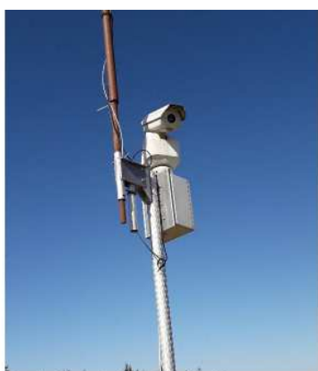
Figure 17 : Caméra thermique située à proximité d'un casier en exploitation
