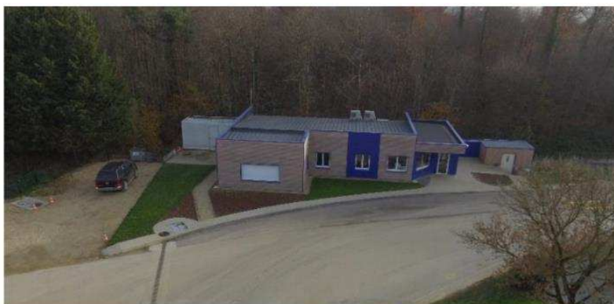
Figure 15 : Vue des bureaux du personnel du site
