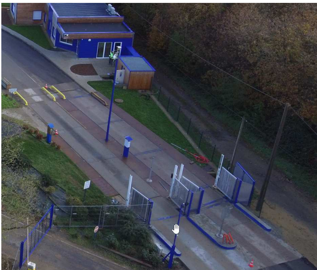
Figure 74 : Installations de contrôles à l'entrée du site
