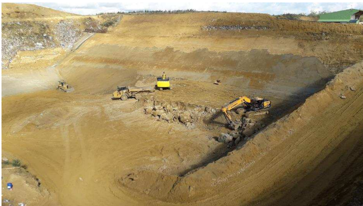
Figure 83 : Casier en cours de terrassement
