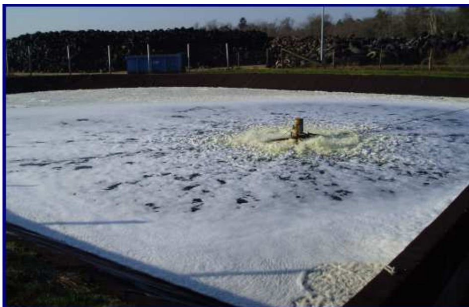
Figure 114 : Lagune à lixiviats avec agitateur
