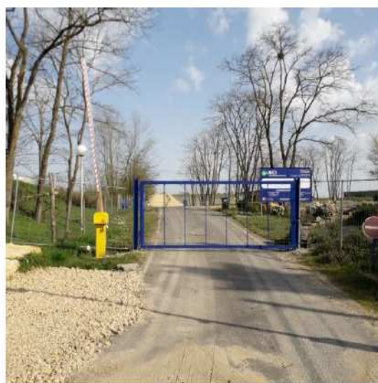
Figure 6 : Portail d'accès pour les engins hors gabarit
