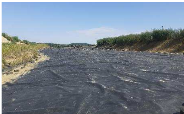
Figure 171 : Casier 7EX recouvert de sa géomembrane
