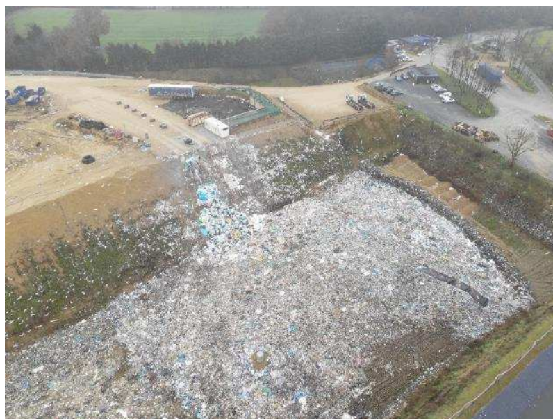
Figure 93 : Photo du quai de vidage
