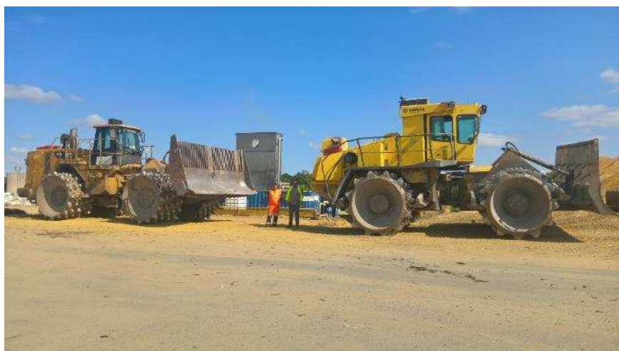
Figure 26 : Photos des engins présents sur site (pelle hydraulique, chariot élévateur et compacteurs)
