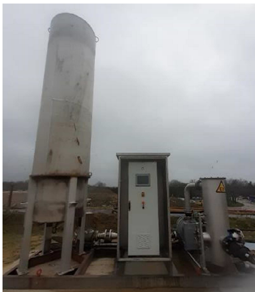
Figure 107 : Seconde torchère mise en service en 2021
