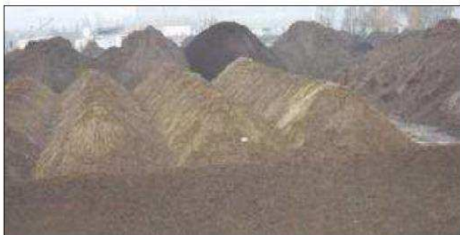
Figure 134 : Exemple d'andains de terres polluées
