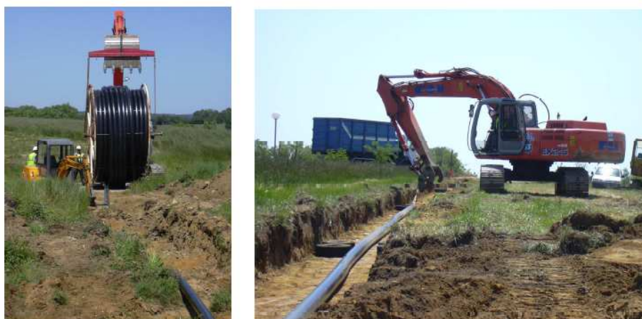
Figure 103 : Mise en place de réseaux de collecte du biogaz – réseau enterré
