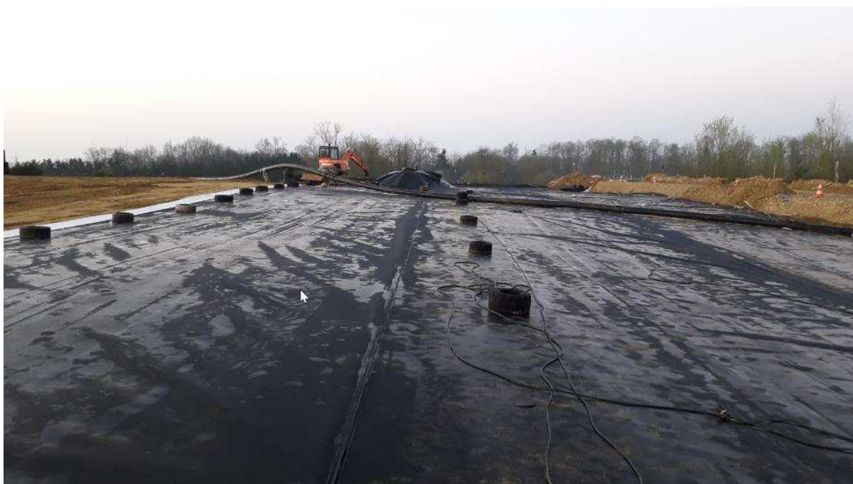
Figure 121 : Mise en place de la couverture finale étanche d'un casier bioréacteur site Terra 72
