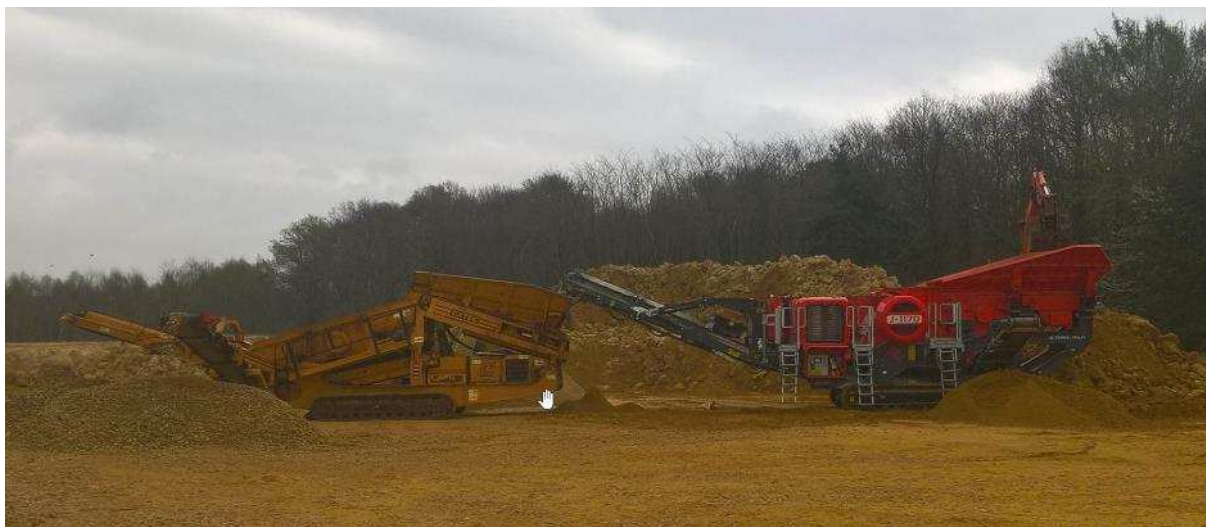
Figure 137 : Photos des opérations de concassage/criblage
