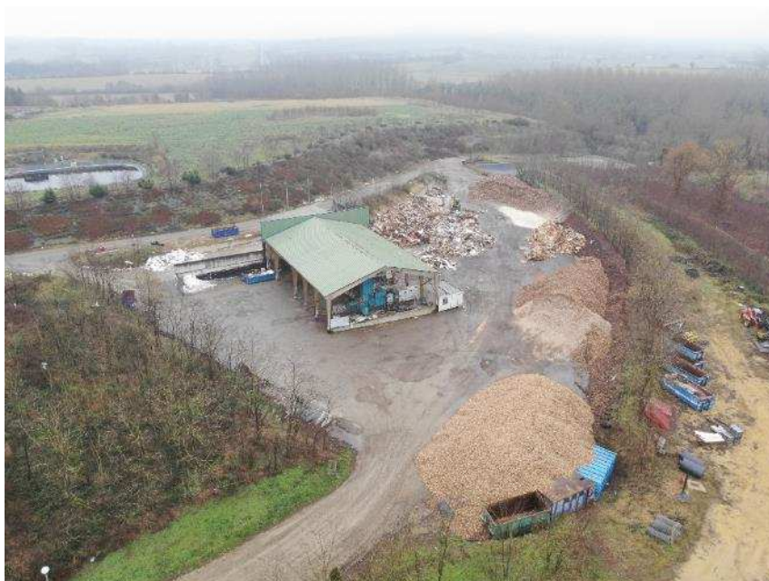
Figure 66 : Vue aérienne de la plateforme actuelle et localisation du hangar et presse à balles
