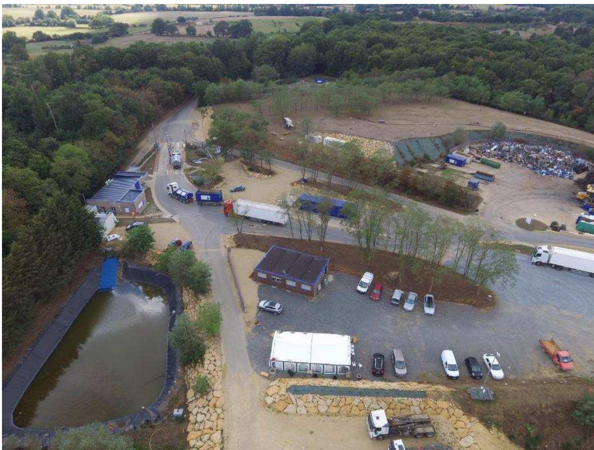
Figure 162 : Photo d'un bassin eaux pluviales
