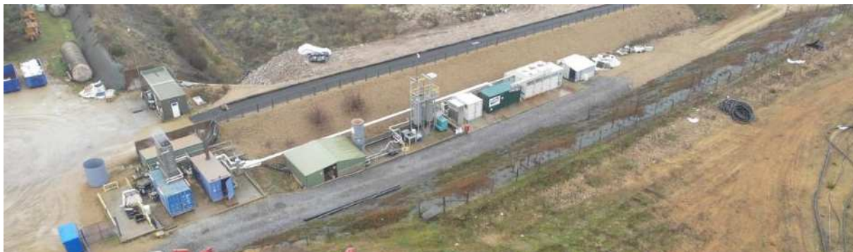
Figure 155 : Installations de valorisation du biogaz et de traitement des lixiviats du site de Montmirail
