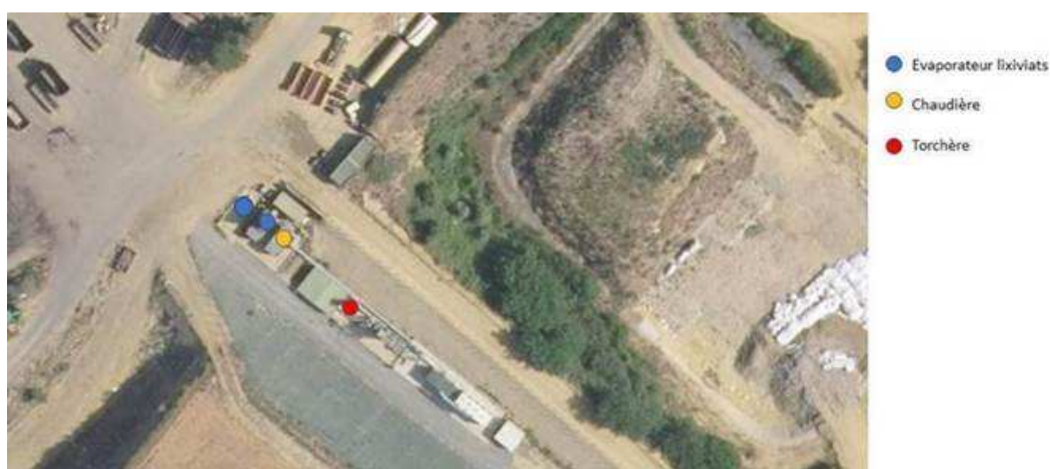
Figure 119 : Localisation des équipements de cogénération, des évaporateurs et de la torchère
