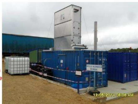
Figure 117 : Vue 3D et photo de l'installation d'évaporation des lixiviats
