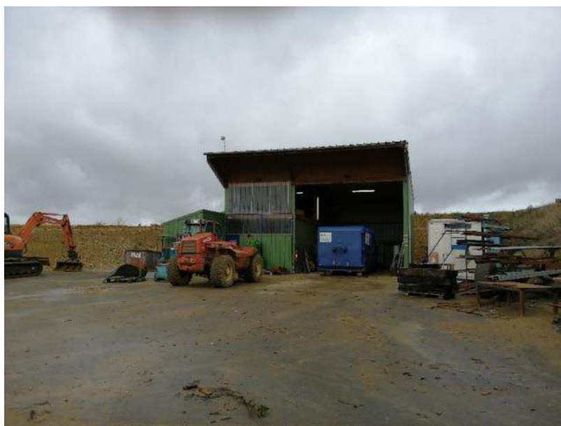
Figure 27 : Vue de l'atelier technique et engins d'exploitation
