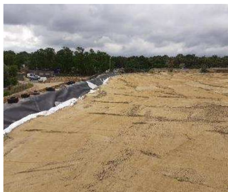
Figure 170 : Déroulement de la géomembrane (à gauche) et recouvrement de terre après pose de géotextile (à droite) sur le casier 12SE
