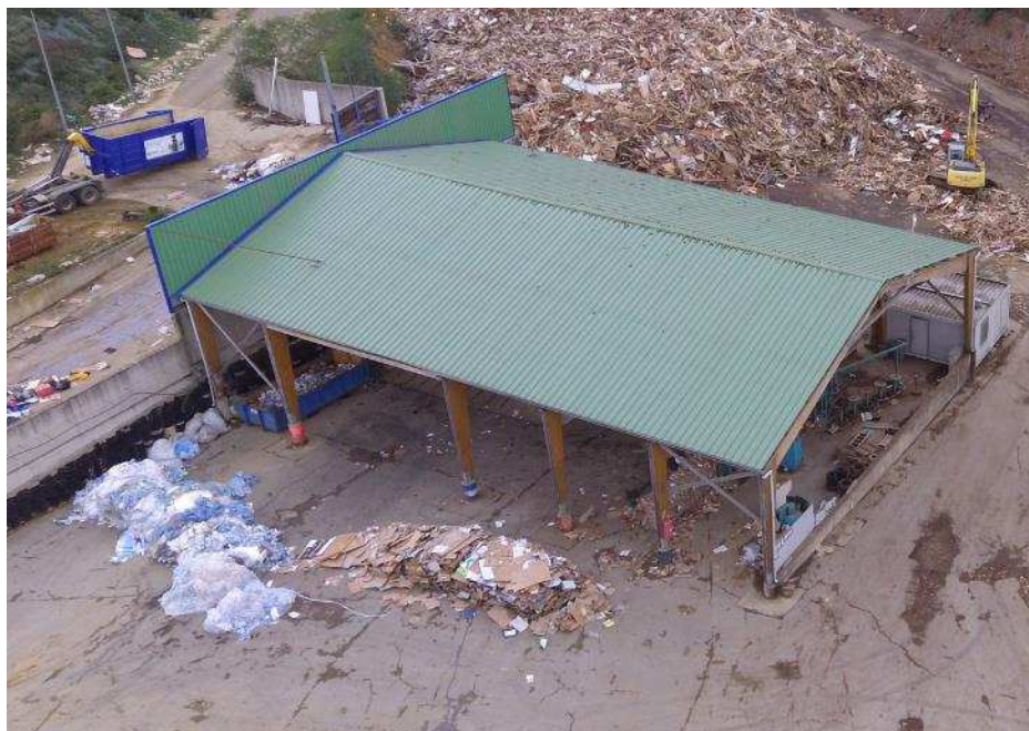
Figure 68 : Déchets de plastiques et cartons avant leur passage dans la presse à balles
