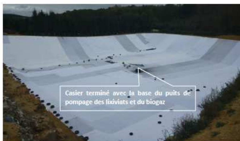
Figure 102 : Exemple de finalisation travaux casier avec mise en œuvre de la base du puits de pompage des lixiviats et du biogaz
