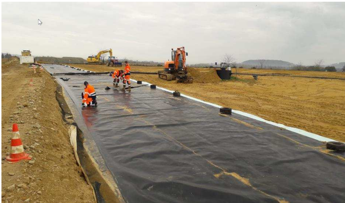
Figure 97 : Vue des travaux de couverture finale d'un casier bioréacteur
