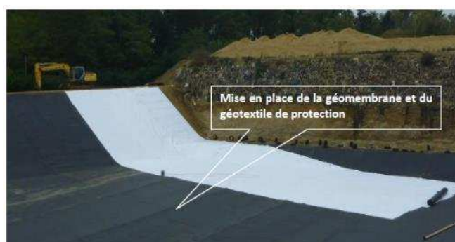
Figure 84 : Vue des travaux d'étanchéité activée par géomembrane des casiers existants de Terra72
