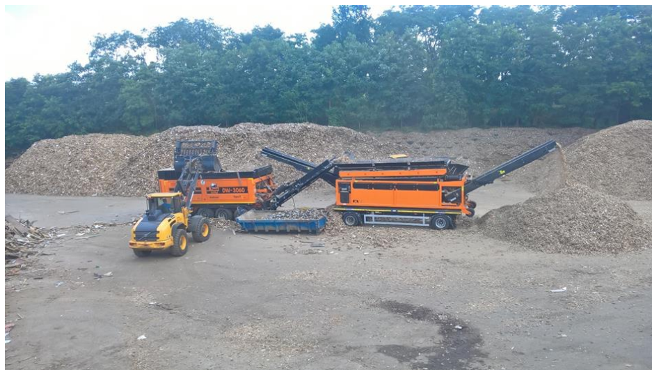
Figure 8 : Opération de broyage de bois sur le site actuel)
