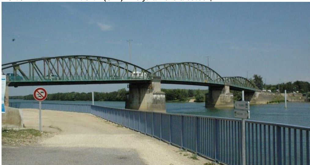
Le pont de Fleurville a été construit en 1899. Photo M. R. (CLP)
