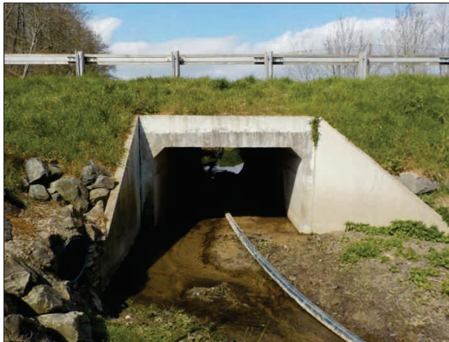
OH 7 : Dalot au droit du ruisseau du Gué des Forges (1600 x 2500 mm) ; rallongement symétrique de part et d'autre de la route
