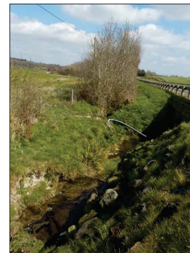
Fossé affluent du Gué des Forges en rive nord de la RD 923, l'élargissement a été effectué sur le côté opposé pour l'épargner.
