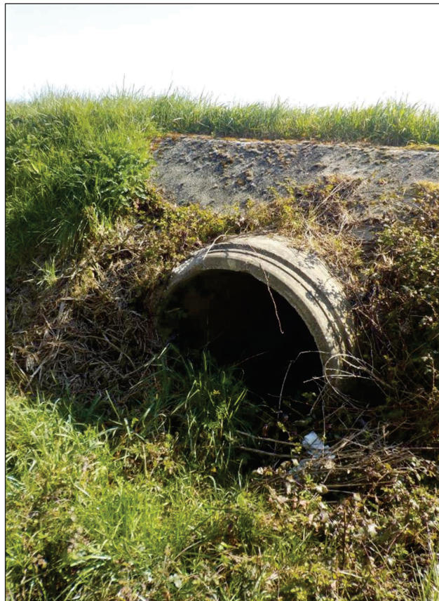
OH 6 : buse de 1000mm pris côté amont de la RD 923
