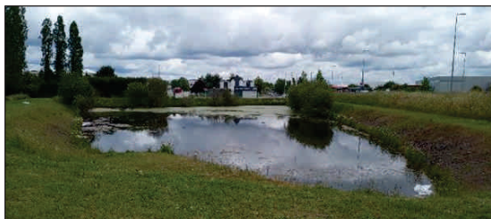
Bassin de décantation aménagé au droit de la zone d'activités de l'Aubinière (au sud de l'A11)
