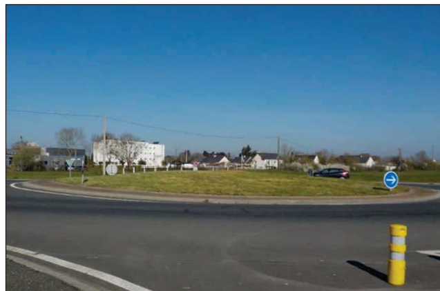
Carrefour giratoire de « La Mondaire », commune de Mésanger (section 1 « Aéroport – Le Houx »)
