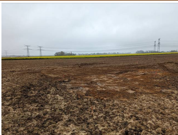
Photographie 6 : Vue d'ensemble à la fin du décapage
