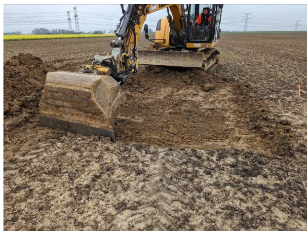
Photographie 2 : Décapage réalisé par bandes successives
