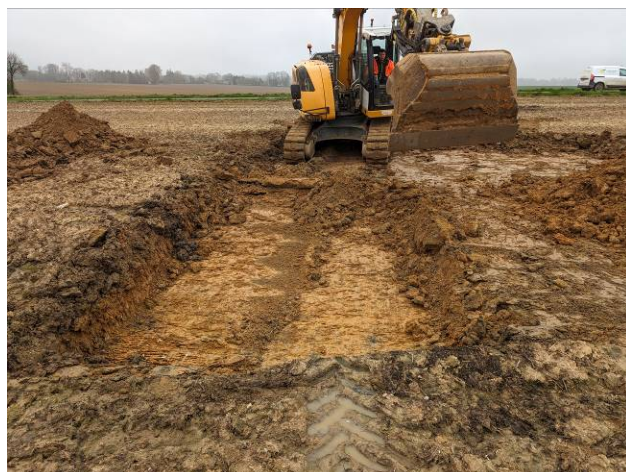
Photographie 8 : Décapage réalisé par bandes successives
