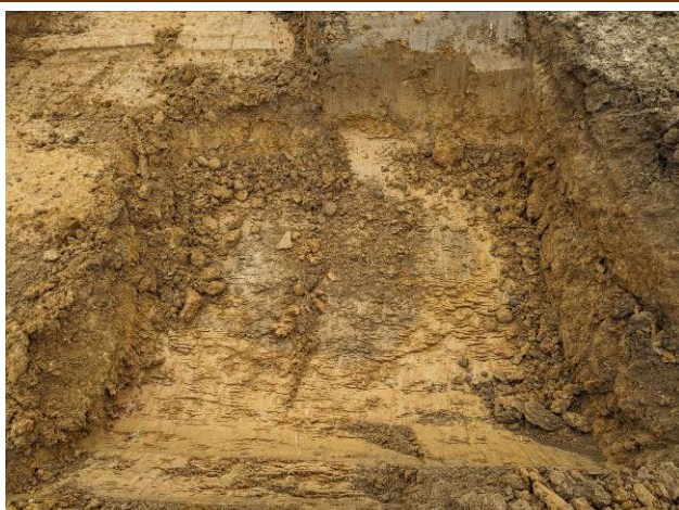
Photographie 10 : Surcreusement de l'anomalie de forme elliptique (environ 2.2m par 2m)
