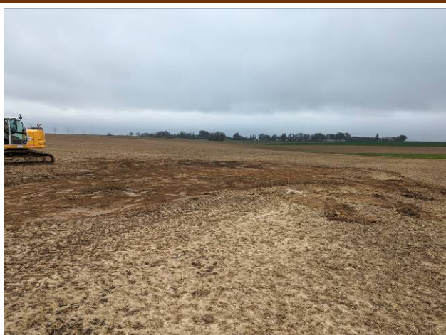
Photographie 12 : Vue d'ensemble à la fin du décapage
