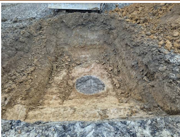
Photographie 5 : Anomalie circulaire toujours présente à 1.5m de profondeur
