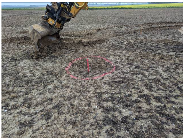
Photographie 1 : Décapage réalisé avec une pelle munie d'un godet cureur
