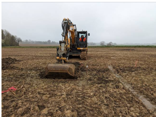
Photographie 7 : Décapage réalisé avec une pelle munie d'un godet cureur
