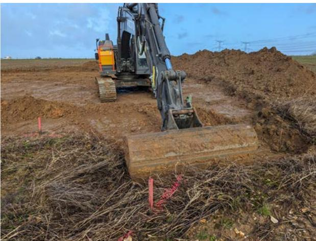
Photographie 3 : Décapage réalisé par bandes successives
