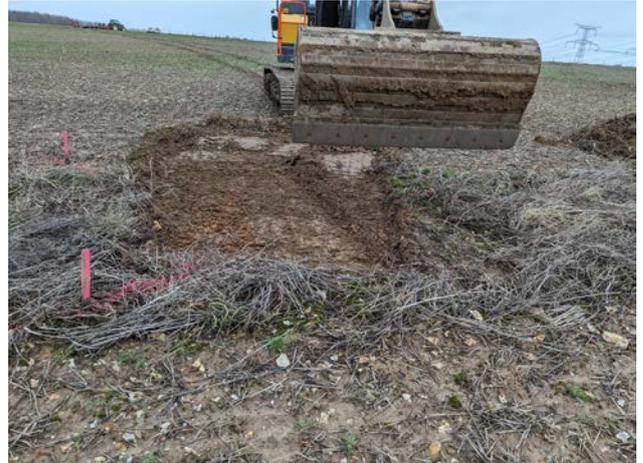
Photographie 2 : Décapage réalisé avec une pelle munie d'un godet cureur
