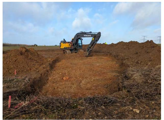
Photographie 6 : Terrain naturel composé d'argile rouge à silex jusqu'à l'arrêt du décapage à 70cm de profondeur
