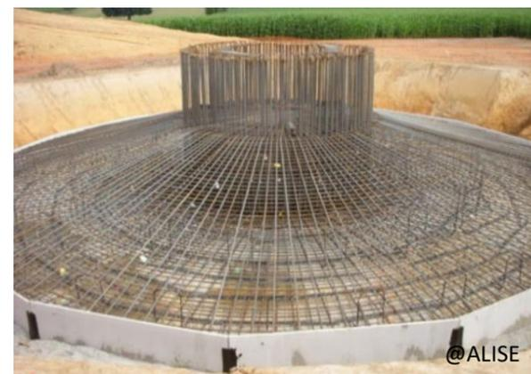
Photo 5 : Excavation et préparation de l'armature
