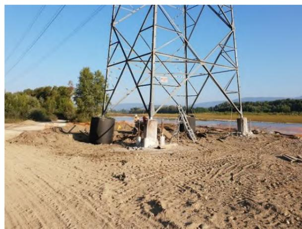
Photo 8 : Renforcement de fondations sur les pylônes de Le Puy-Sainte-Reparate en 2018 (source : RTE)
