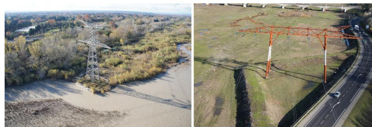
Photo 1 : Pylône 201 en treillis à gauche et 215 en tubulaire à droite (source : RTE, 2019)
