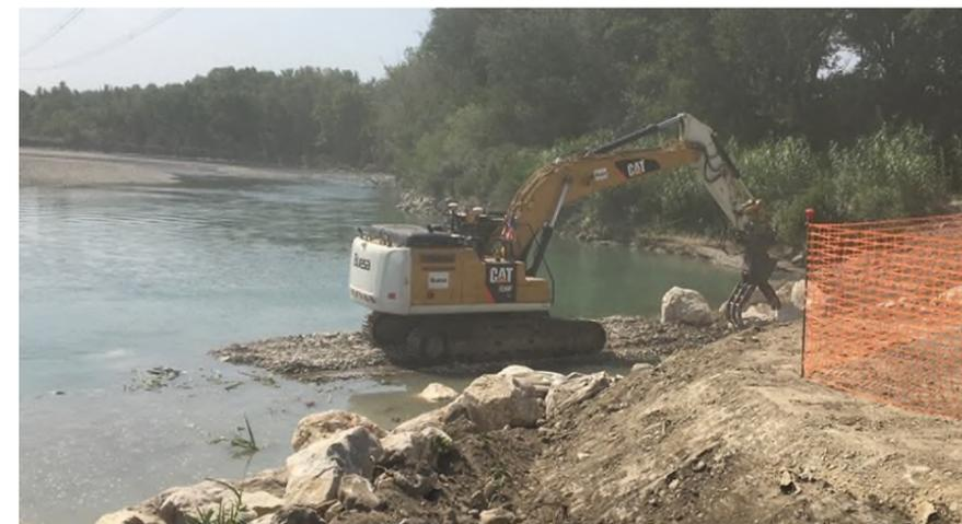
Figure 12 : Isolement des travaux d'enrochement des écoulements du lit vif
