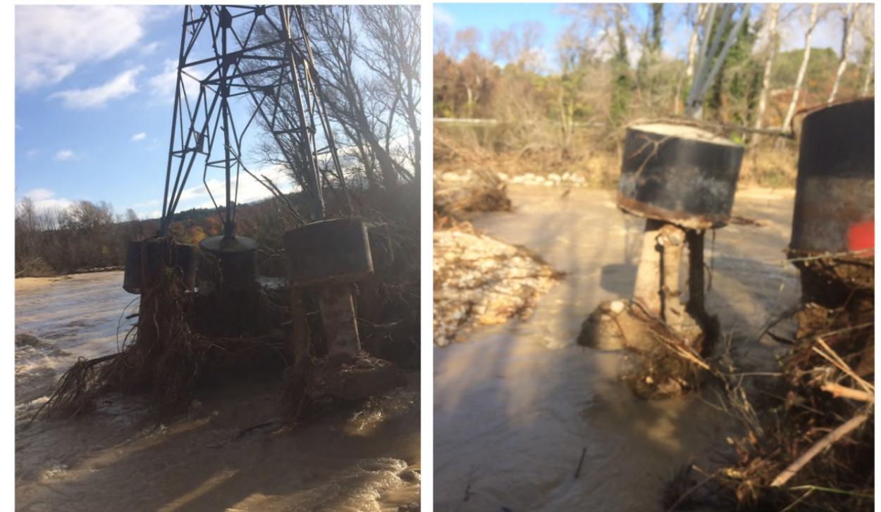
Photo 23 : Illustration des impacts d'une crue de du Calavon sur un pylône 63kV (Apt-Beaumettes) lors des crues de novembre 2019
