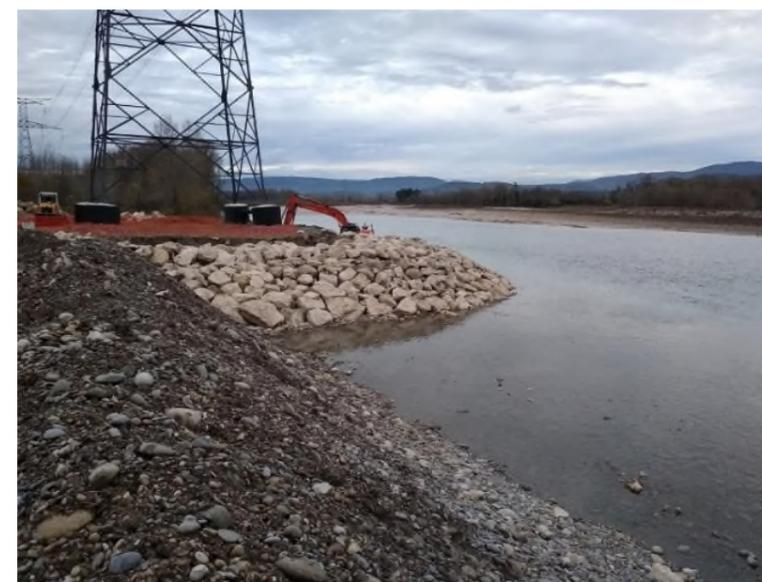
Photo 5 : Réalisation d'enrochements en 2018 sur le pylône 89 (source : RTE)
