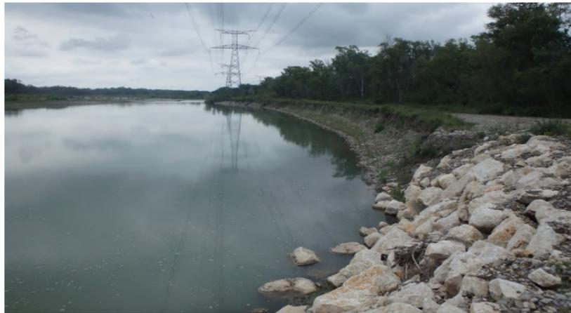
Photo 3 : Illustration de l'érosion latérale entre les pylônes 88 et 89 (source : setec, 2018)
