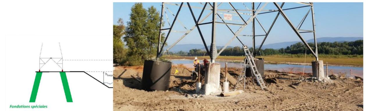
Figure 4 : Schéma d'une fondation spéciale
