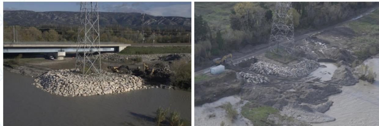
Photo 6 : Réalisation d'enrochements en 2018 sur le pylône 180 (en haut) et le pylône 236 (en bas) (source : RTE)
