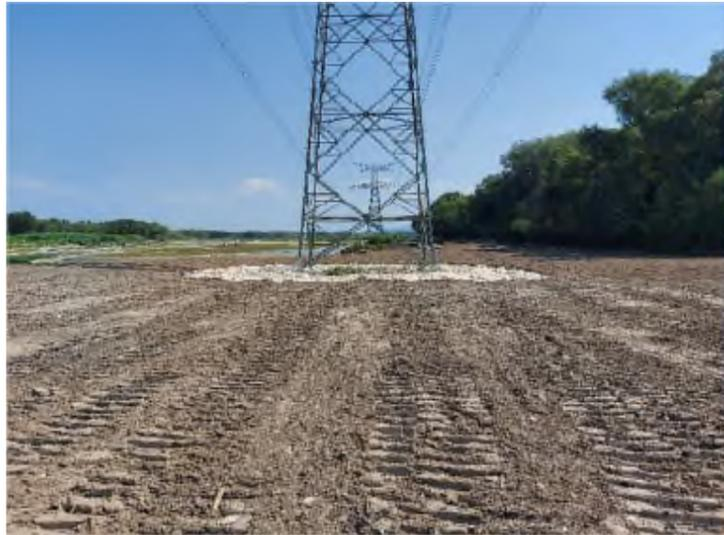
Photo 15 : Pylône 211 dont les enrochements effectués en 2020 sont majoritairement recouverts (source : RTE)
