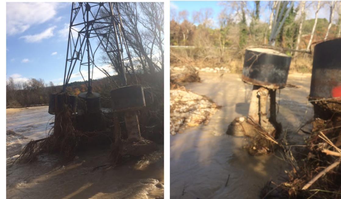
Figure 6 : Illustration des impacts d'une crue de du Calavon sur un pylône 63kV (Apt-Beaumettes) lors des crues de novembre 2019
