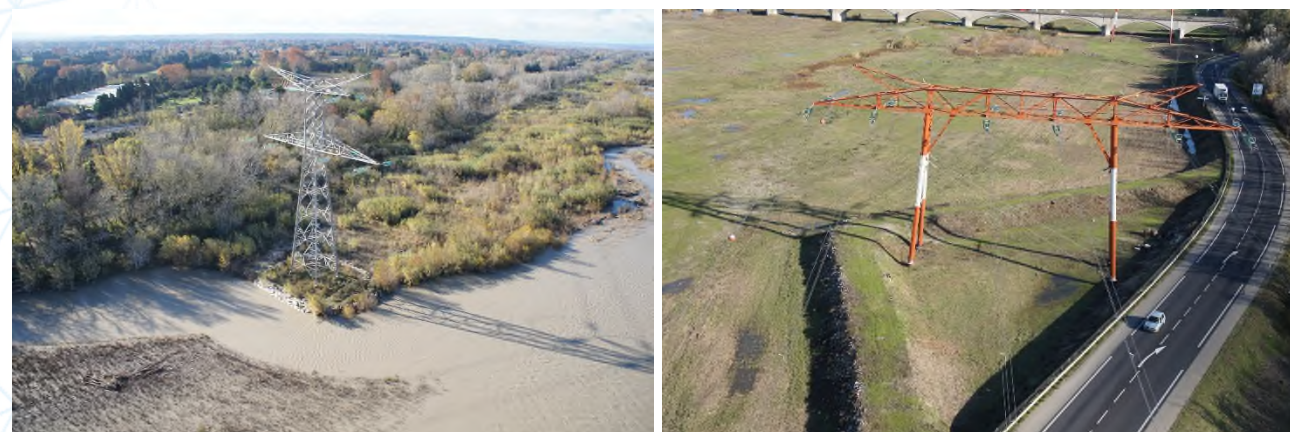
Photo 10 : Pylône 201 en treillis à gauche et 215 en tubulaire à droite (source : RTE, 2019)
