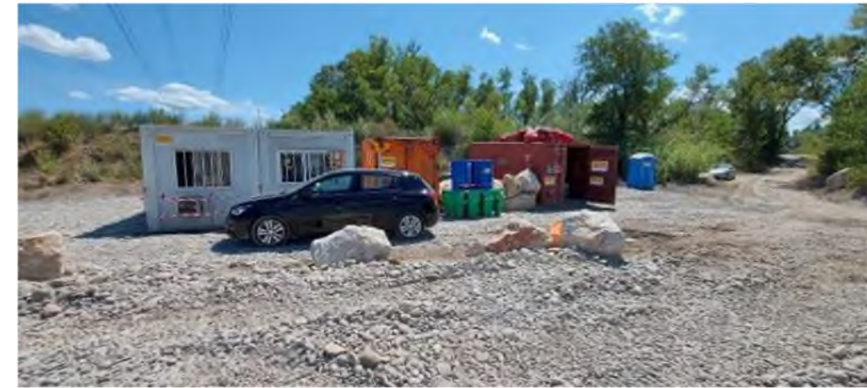
Figure 18 : Photos d'installations de chantier lors d'opérations d'enrochements en Durance
