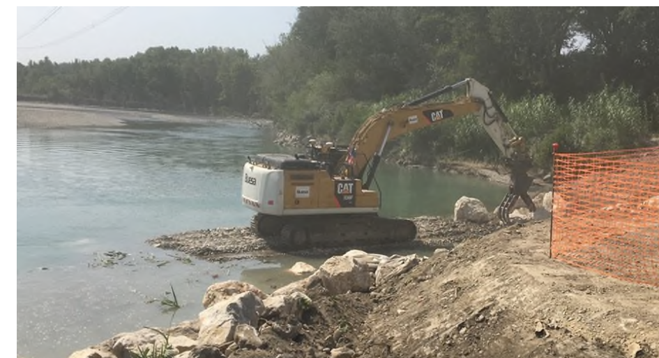
Photo 21 : Isolement des travaux d'enrochement des écoulements du lit vif
