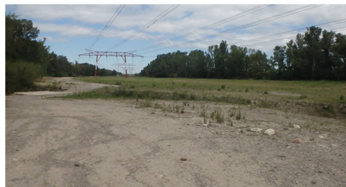
Photo 22 : Illustration de travaux de désenlimonement
