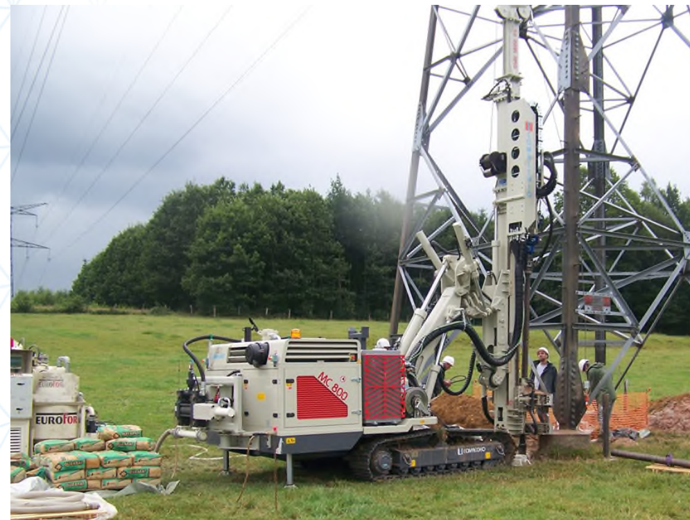
Photo 18 : Forage (source : EGERI Fondations spéciales au moyen de micropieux)
