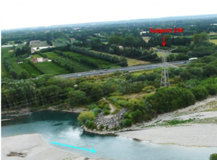
Photo 15 : Exemple d'épis réalisé lors de la création de l'autoroute, au droit du pylône 194 (source : étude ARTELIA, 2015)
