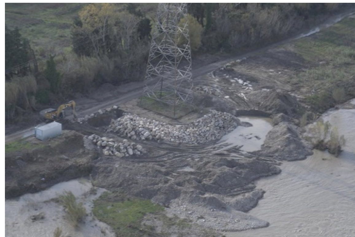
Photo 4 : Réalisation d'enrochements en 2018 sur le pylône 180 (en haut) et le pylône 236 (en bas) (source : RTE)
