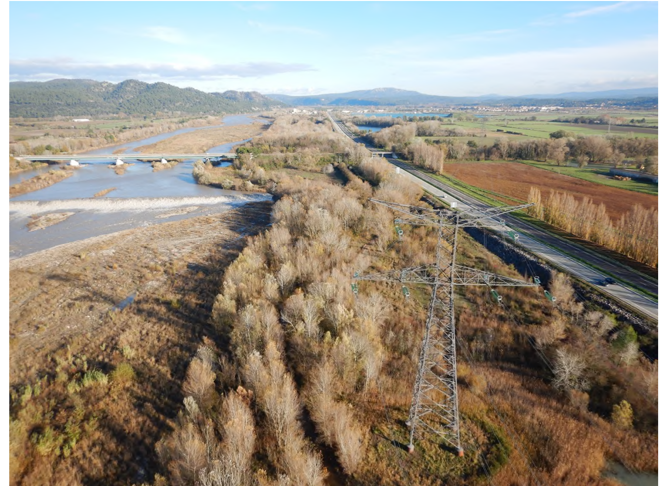
Photo 1 : Pylône 63 en rive droite de la Durance (source : RTE)
