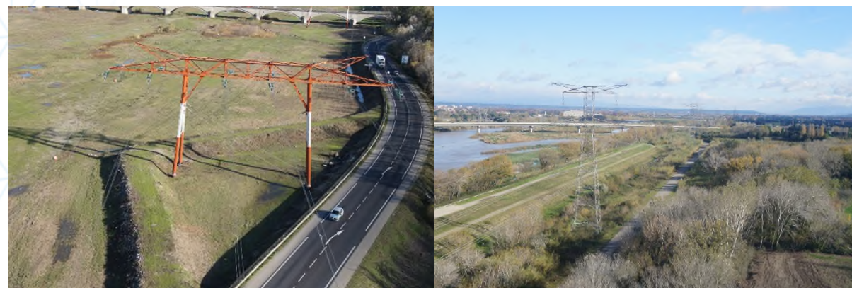
Photo 16 : Digues localisées (pylône 215 à gauche) ou latérales au cours d'eau (pylône 245, à droite) (source : RTE, 2019)
