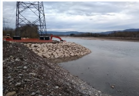
Photo 3 : Réalisation d'enrochements en 2018 sur le pylône 89 (source : RTE)
