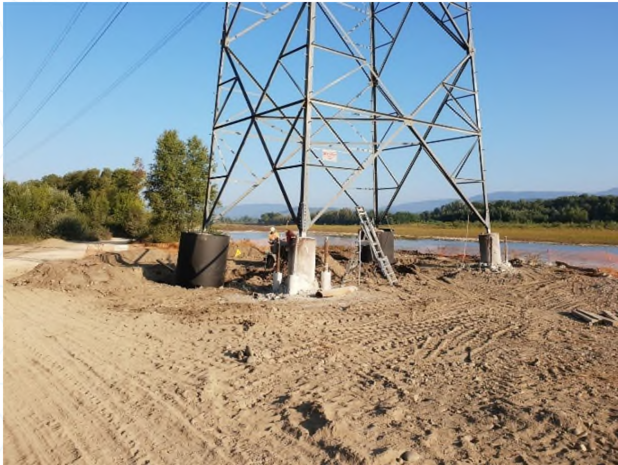
Photo 7 : Renforcement de fondations sur les pylônes de Le Puy-Sainte-Reparate en 2018 (source : RTE)
