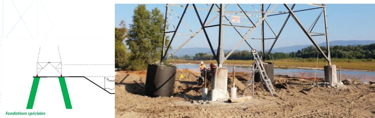
Figure 4 : Schéma d'une fondation spéciale
