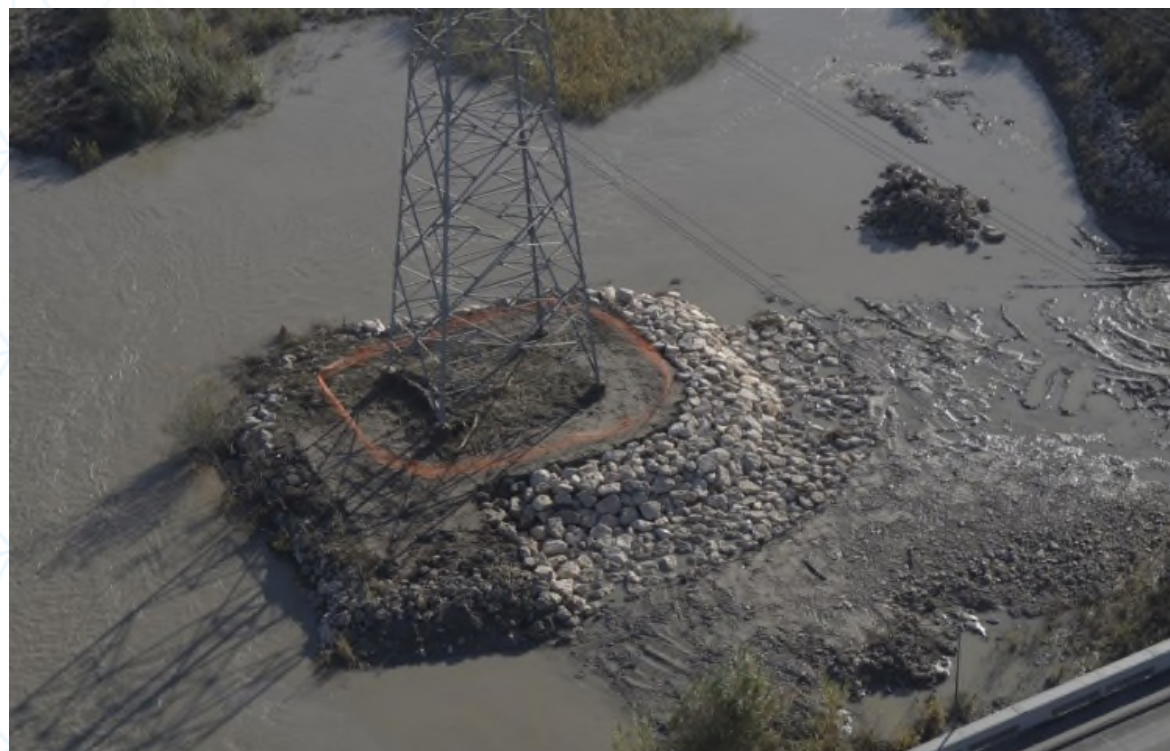
Photo 5 : Réalisation d'enrochements en 2018 sur le pylône 195 (en haut) et 186 (en bas) (source : RTE)
