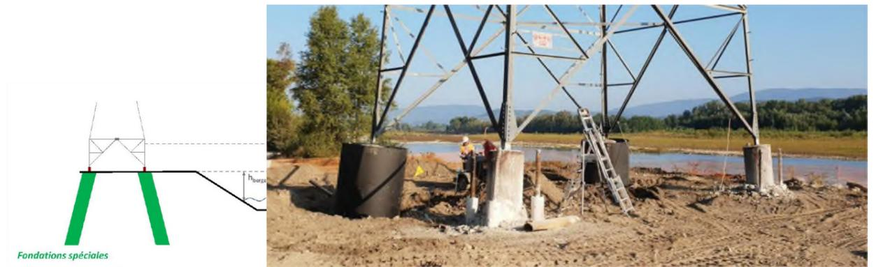
Figure 4 : Schéma d'une fondation spéciale et illustration photographique
