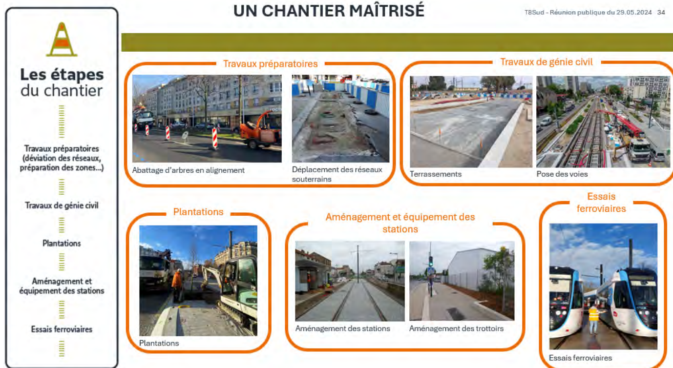
Figure 72 : Les étapes type d'un chantier de tramway (Support de la réunion publique T8Sud du 29/05/2024)
