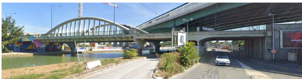
Figure 48 : Secteur du pont de Pressensé (vue depuis l'avenue du Général de Gaulle / quai A. Agnès - RD24)
