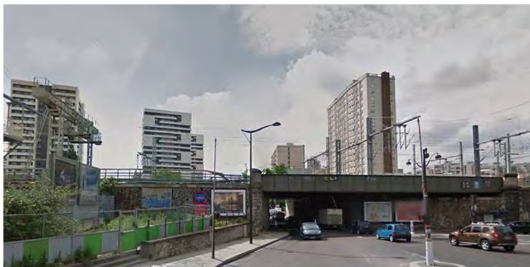
Figure 35 - Pont-rail SNCF rue d'Aubervilliers avant élargissement (mai 2014)
