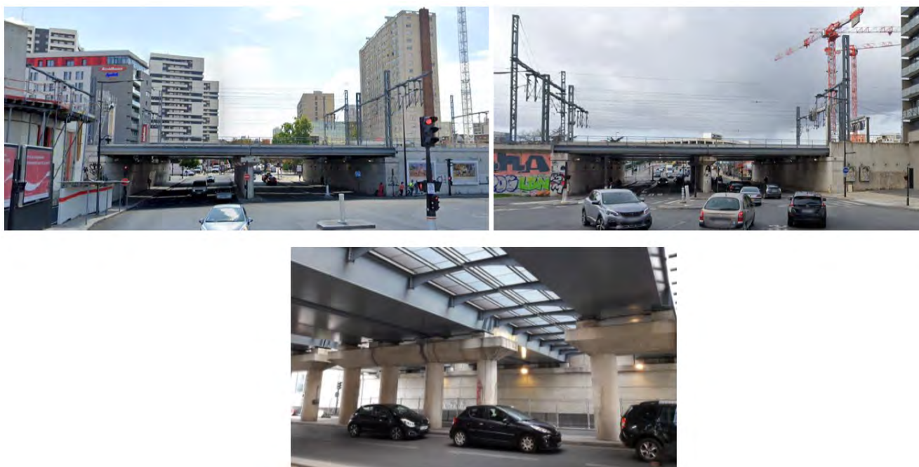
Figure 34 - Ouvrages ponts-rail SNCF rue d'Aubervilliers (RER E) avec pile centrale
