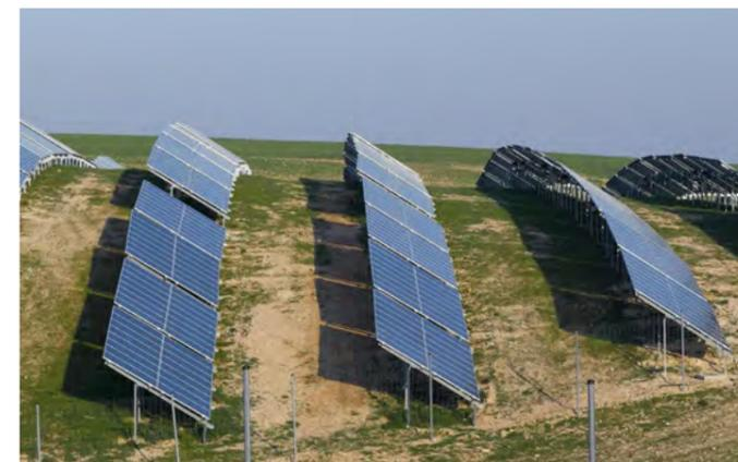
**Exemple d'implantation de modules épousant la topographie sur des terrains en pentes transversales, permettant de suivre le relief et éviter des cassures visuelles trop importantes.**
