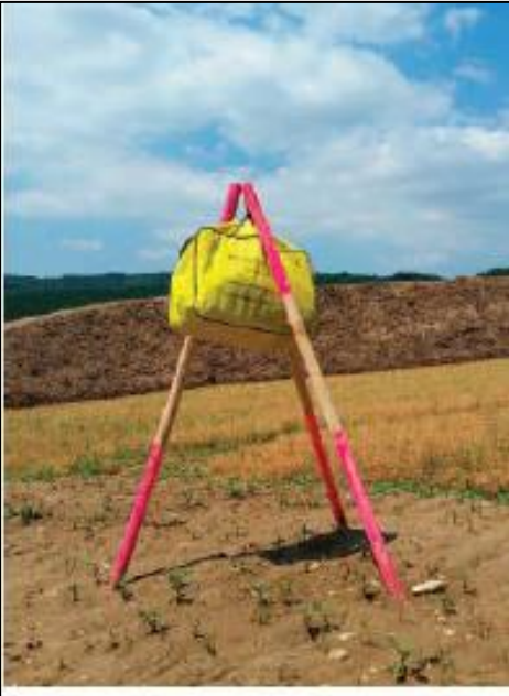
Figure 31 : Exemple de kit anti-pollution isolé du sol (Guide technique "Protection des milieux aquatiques en phase chantier", AFB, 2018)
