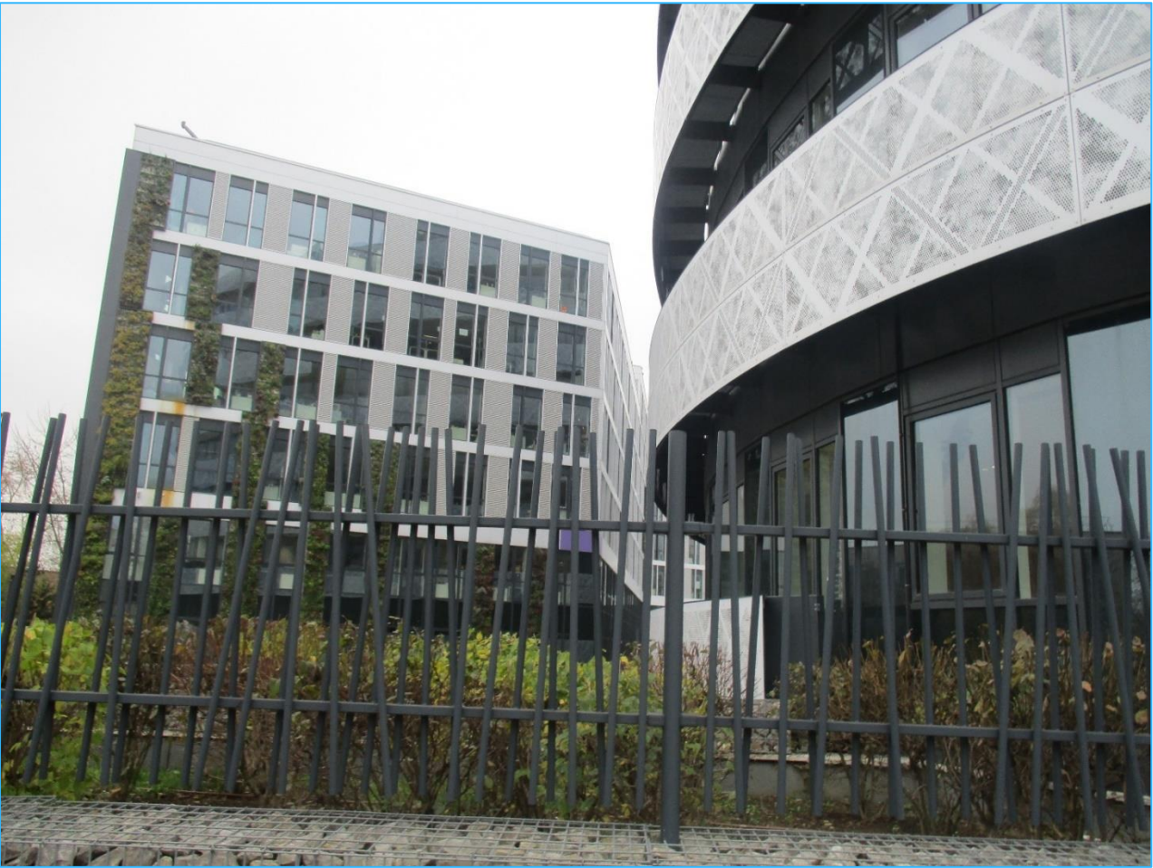
Figure 44 : Photographie de l'Eco-Campus ORANGE (Source : Ségic Ingénierie)
