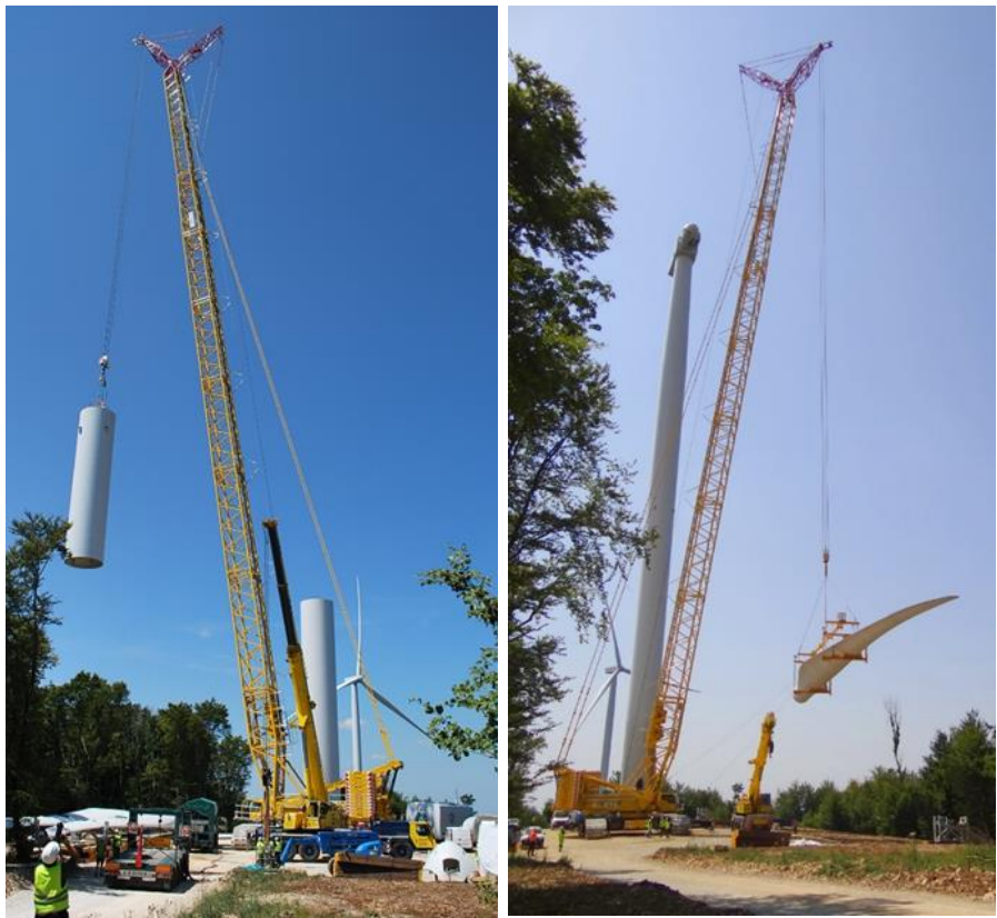
Photo 9 : Exemple de montage d'une éolienne
