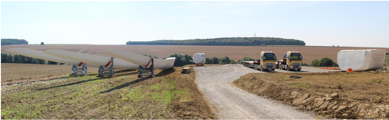
Photo 8 : Éléments d'éoliennes avant montage
