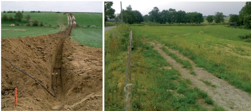
Photo 5 : Exemple de tranchée ouverte et de tranchée fermée depuis 2 mois
