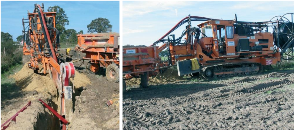
Photo 4 : Trancheuse en action
