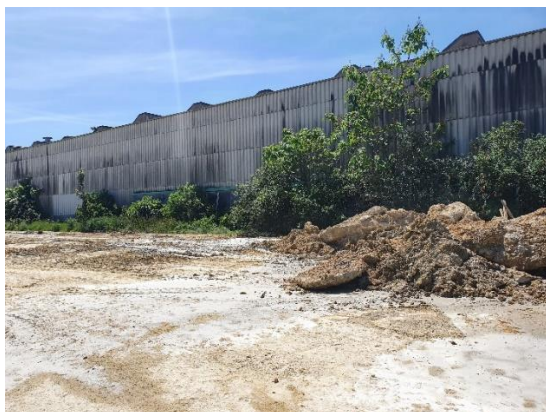
Bâtiment vue extérieure - Juin 2021
