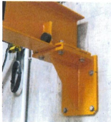
La Fixation peut se faire sur sabot mural ou corbeaux qui sont un système de fixation mural « à l'équerre ». Ce type de fixation est particulièrement utile dans les cas où la reprise au sol ou sous plafond est impossible.
