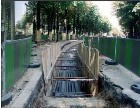
Figure 10 Tranchée lors de la pose d'une liaison double en PVC
