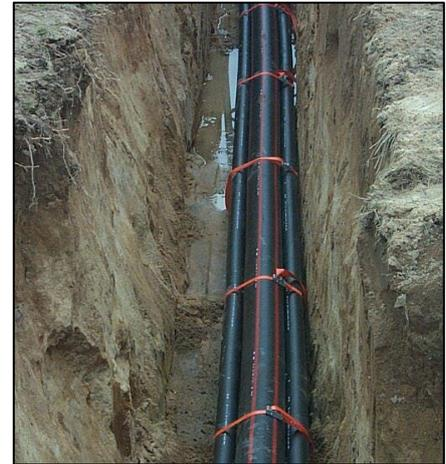
Figure 9 Tranchée lors de la pose d'une liaison double en PEHD
