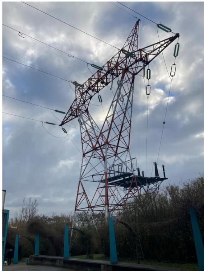
*Figure 13 Photo du pylône 20 déjà équipée d'une plateforme*
