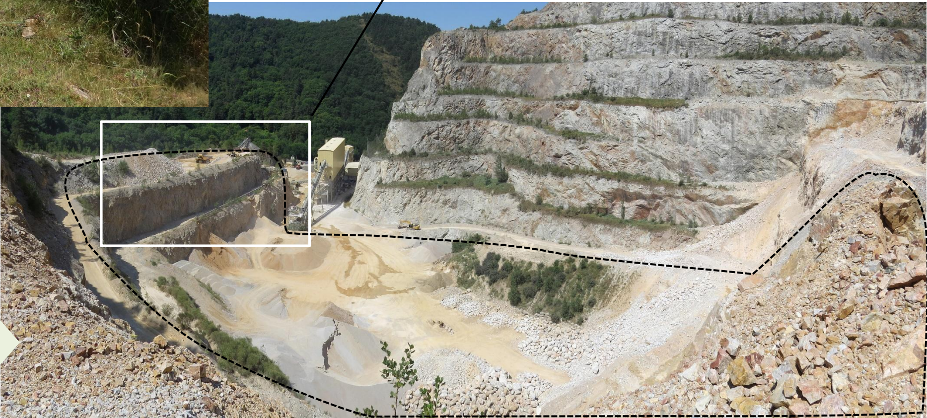
Photo 3 : Vue sur le secteur de la carrière concerné par l’extraction sollicitée, avec à gauche, l’éperon rocheux accueillant actuellement la trémie d’alimentation du poste primaire, et au centre, le carreau à approfondir de 4 paliers de 15 m.
