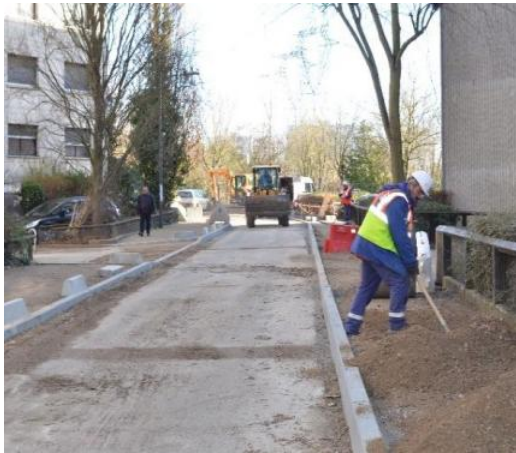
Travaux rue Lefebvre
