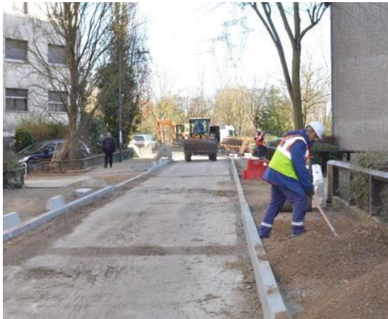
Travaux rue Lefebvre
