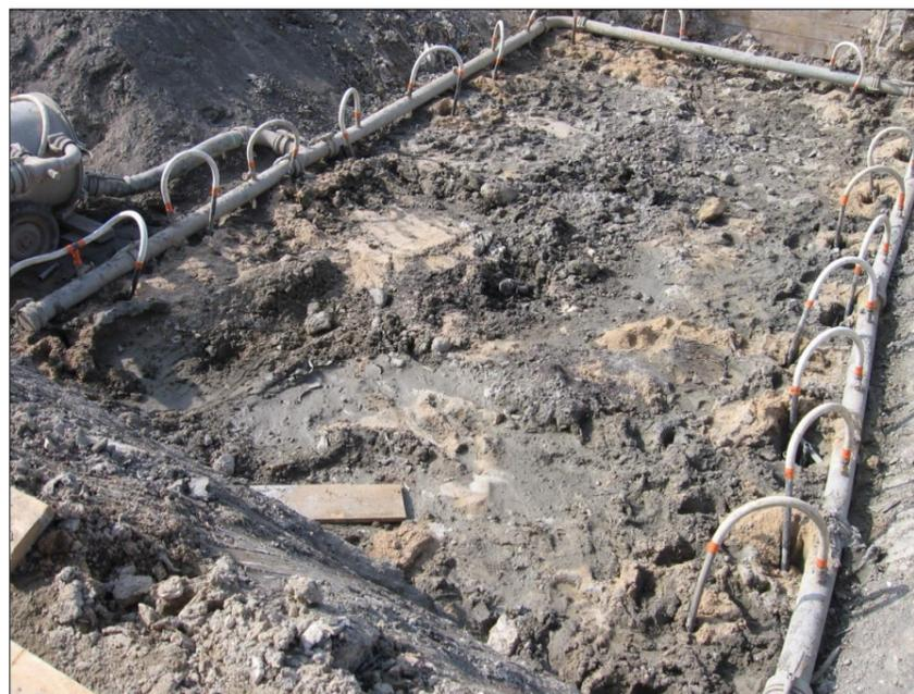
Figure 42 : Dispositif de rabattement de nappe par pointes filtrantes
