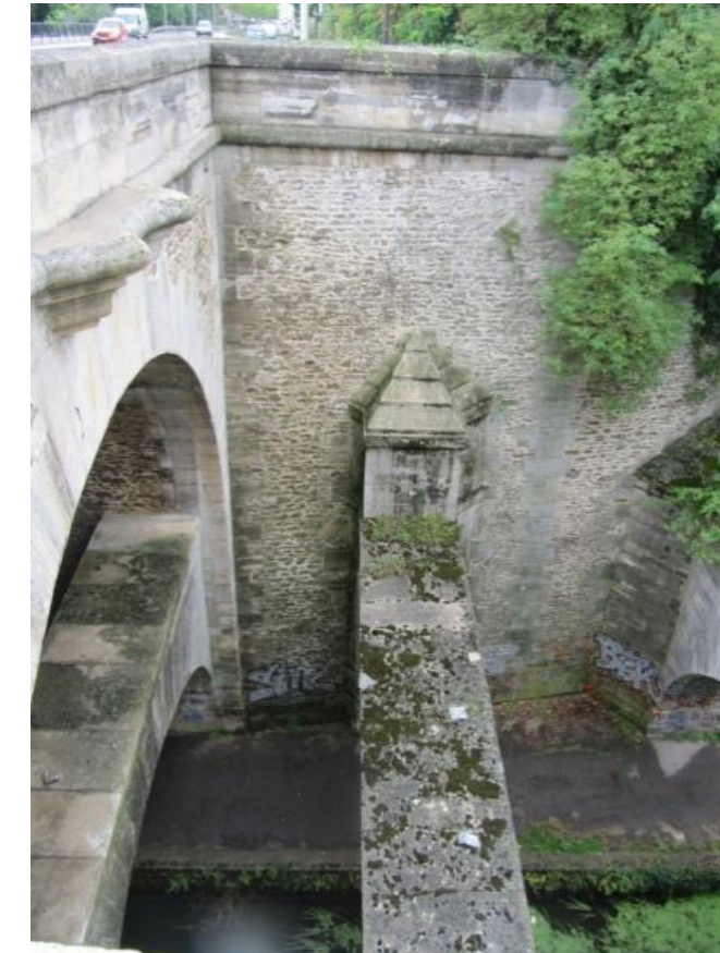
156 – Vue sur le Pont des Belles Fontaines
