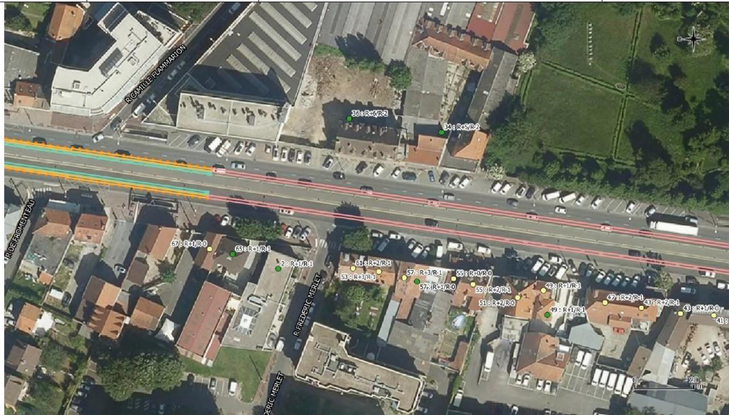
Figure 72 : Sensibilité du parc bâti aux déformations (1/5)
