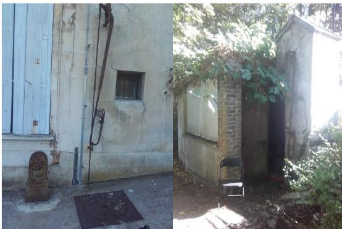
Figure 39 - Puits P3 (à gauche) et P2 (à droite) du Parc Camille Flammarion
