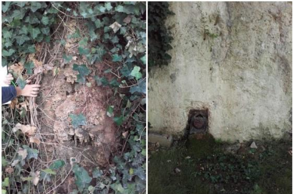
Figure 32 -Source hôpital – Ecoulement provenant de l'effet barrage générée par l'ouvrage de soutènement (n°5) – Vue des écoulements permanents se déversant dans le réseau d'eau pluviale (à gauche) et de l'apparition d'efflorescences en tête de la paroi moulée (à droite)
