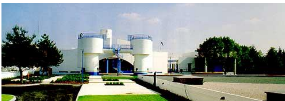
Figure 37 – Usine de production d’eau potable de Vigneux-sur-Seine
